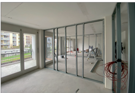
Umbauphase (neue Metallständer für GK-Wände)
